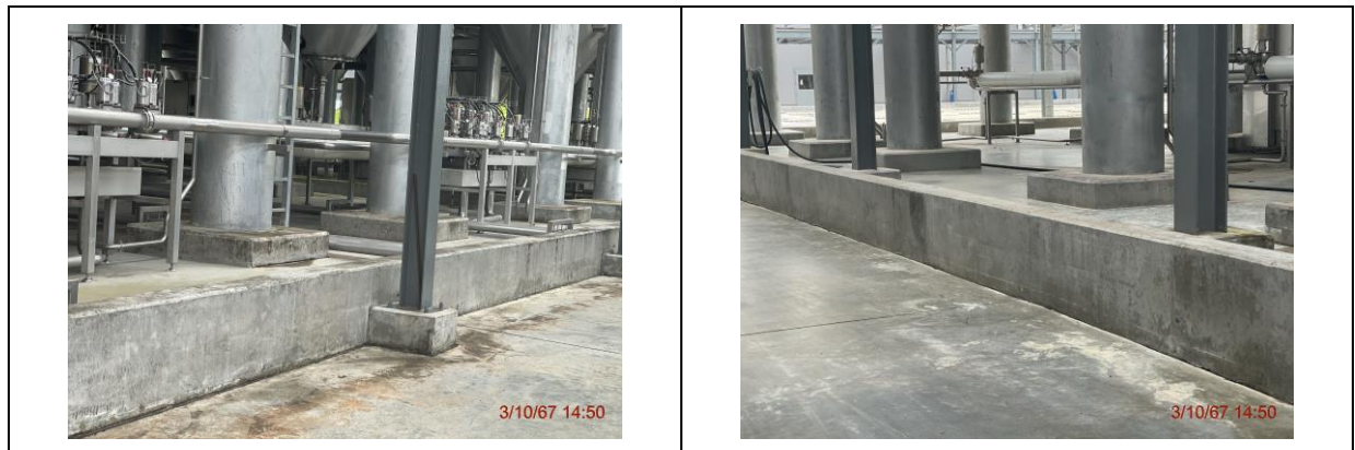
รูปที่ 20 คันคอนกรีตล้อมรอบถังเก็บผลิตภัณฑ์
