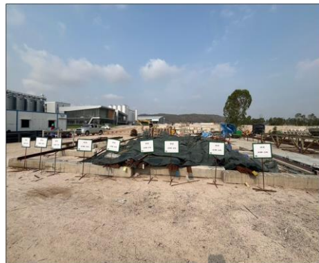
รูปที่ 5 การปิดคลุมกองวัสดุก่อสร้าง
