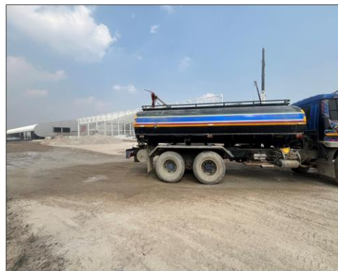
รูปที่ 6 การฉีดพรมน้ำในพื้นที่ก่อสร้าง
