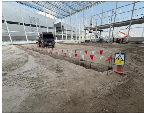
รูปที่ 2 การกันเขตพื้นที่ที่มีการขุด
